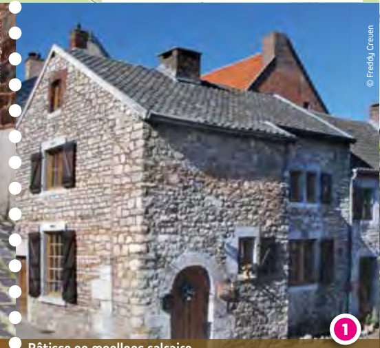
Bâtisse en moellons calcaire Metselwerk in kalksteen / Gebäude aus Kalkbruchsteinen
