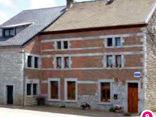
Maison Warnier Huis Warnier / Haus Warnier
