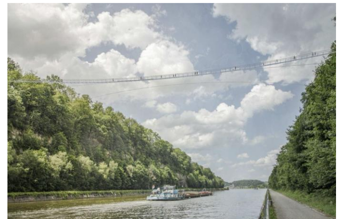
Passerelle de Caster
